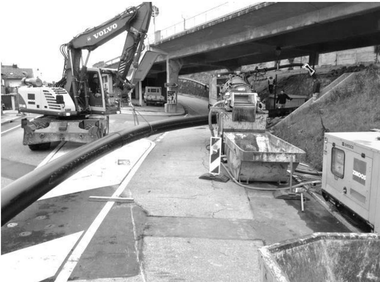
Figure 1 : mise en place d'une canalisation par forage dirigé, route de Lausanne, Cully
