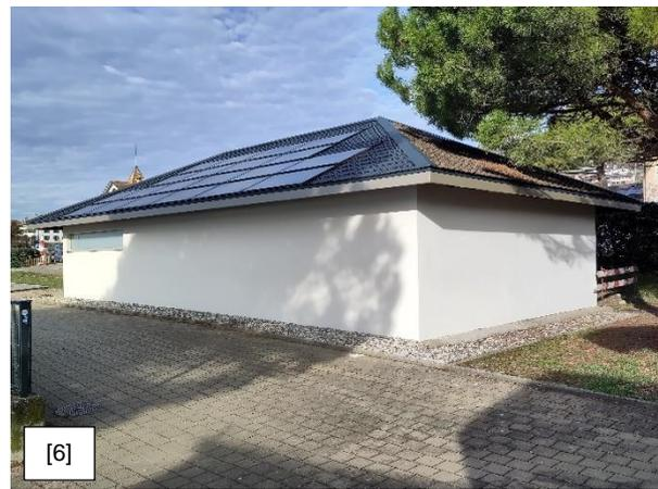
Les 80 m<sup>2</sup> de panneaux solaires ont produit environ 17'000 kWh.
