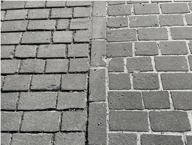
Pavage pierre naturelle avec joint sable (à gauche) et joint mortier (à droite)
